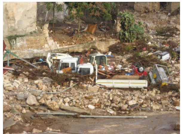
Evento alluvionale ottobre 2013: Ponte San Leonardo Via Puglie/SP ex SS 580 sul Torrente Lognone Tondo nel Centro abitato Ginosa: ostruzione del ponte, crollo di alcune abitazioni, accumulo di fanghi, resti vegetali e rifiuti antropici in alveo e nelle cavità nelle cavità antropiche presenti lungo le sponde
