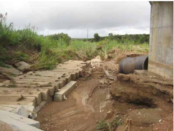
Evento alluvionale ottobre 2013: attraversamento sul Torrente Gravinella del Canale e dell' Adduttore idrico del Sinni nel tratto gestito da Acquedotto Pugliese: Le portate di piena hanno determinato la rottura dell'adduttore idrico.
