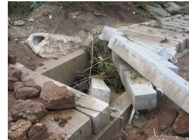
Evento alluvionale ottobre 2013: attraversamento sul Torrente Gravinella del Canale e dell' Adduttore idrico del Sinni nel tratto gestito da Acquedotto Pugliese: Le portate di piena hanno determinato la rottura dell'adduttore idrico.
