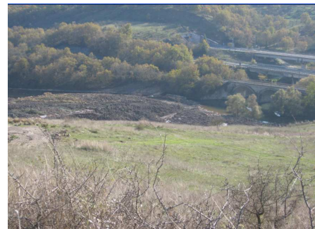
Fiume Basento: Tricarico. Il cumulo di frana ha ostruito l'alveo del fiume a valle del ponte ferroviario e dei viadotti della S.S. 407 Basentana
